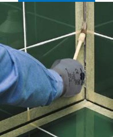
Application of Primer FD
