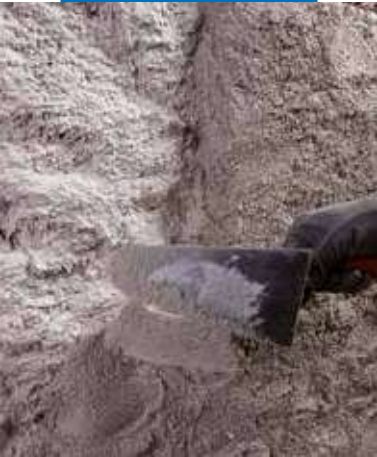
Applying Mape-Antique MC over Mape-Antique Rinzafo
