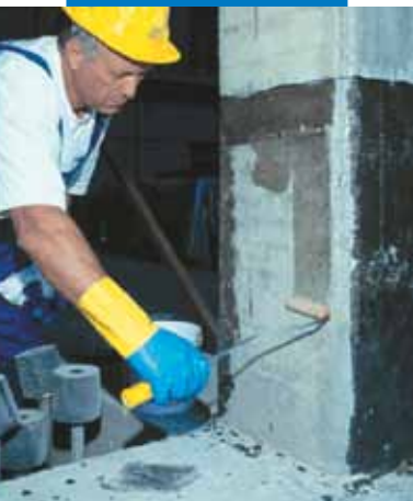
Applying a coat of MapeWrap Primer 1
