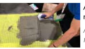
Assicurarsi di rasare il collante e colmare completamente le cavità cilindriche della membrana con una spatola liscia e successivamente con una spatola dentata idonea.
