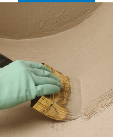
Στεγάνωση λεπτομερειών με πινέλο
