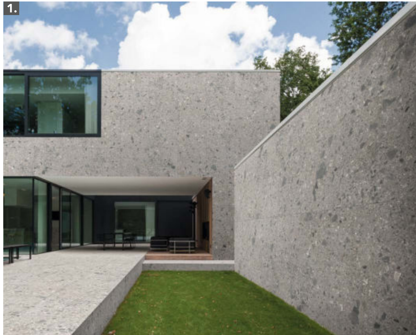
Lastre incollate su cappotto. - Slabs bonded on over-coat.
